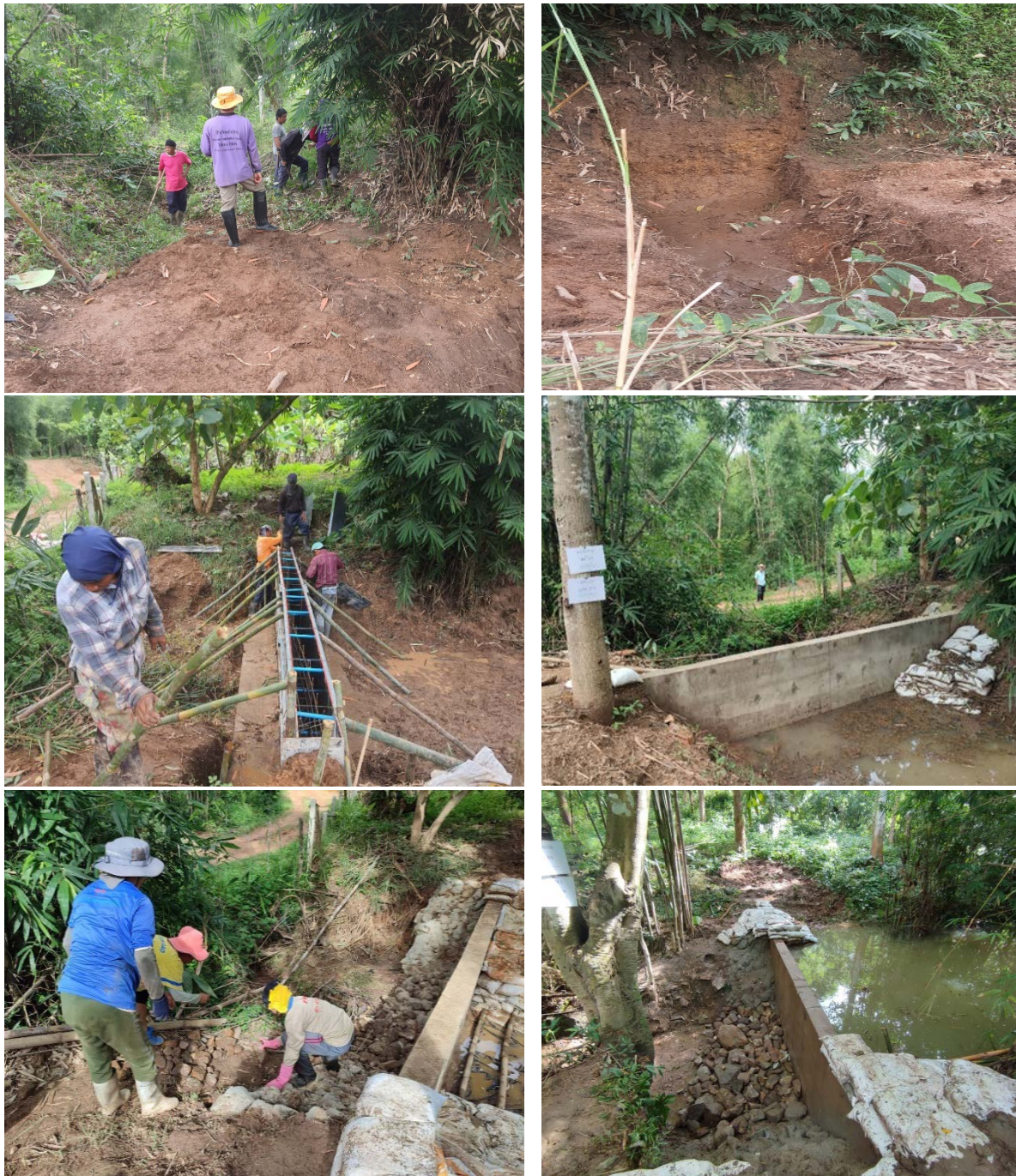
ภาพที่ 5.2-5 การสร้างฝายชะลอน้ำแบบกึ่งถาวร 6 แห่ง
