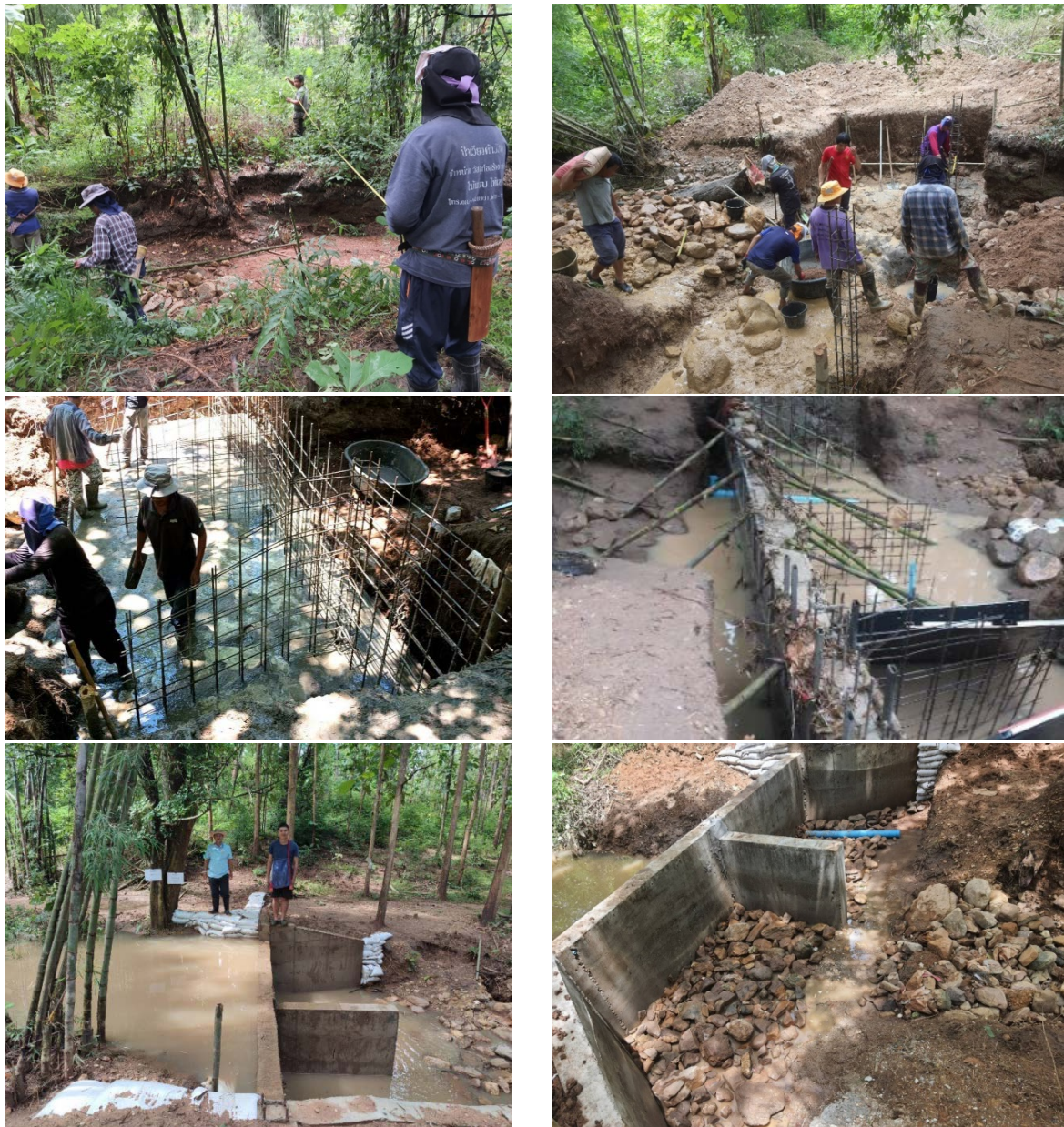
ภาพที่ 5.2-6 สร้างฝายชะลอน้ำแบบถาวร จำนวน 4 แห่ง
